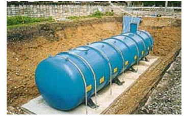
【耐震性貯水槽】
