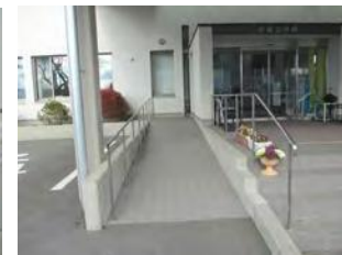
出入口の段差解消 事業費：30万円程度
