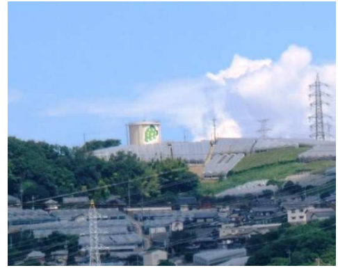
山上の配水施設
