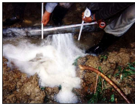
パイプラインの漏水
