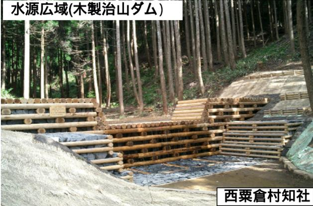
山地治山(間伐材残存型枠を用いた治山ダム)
