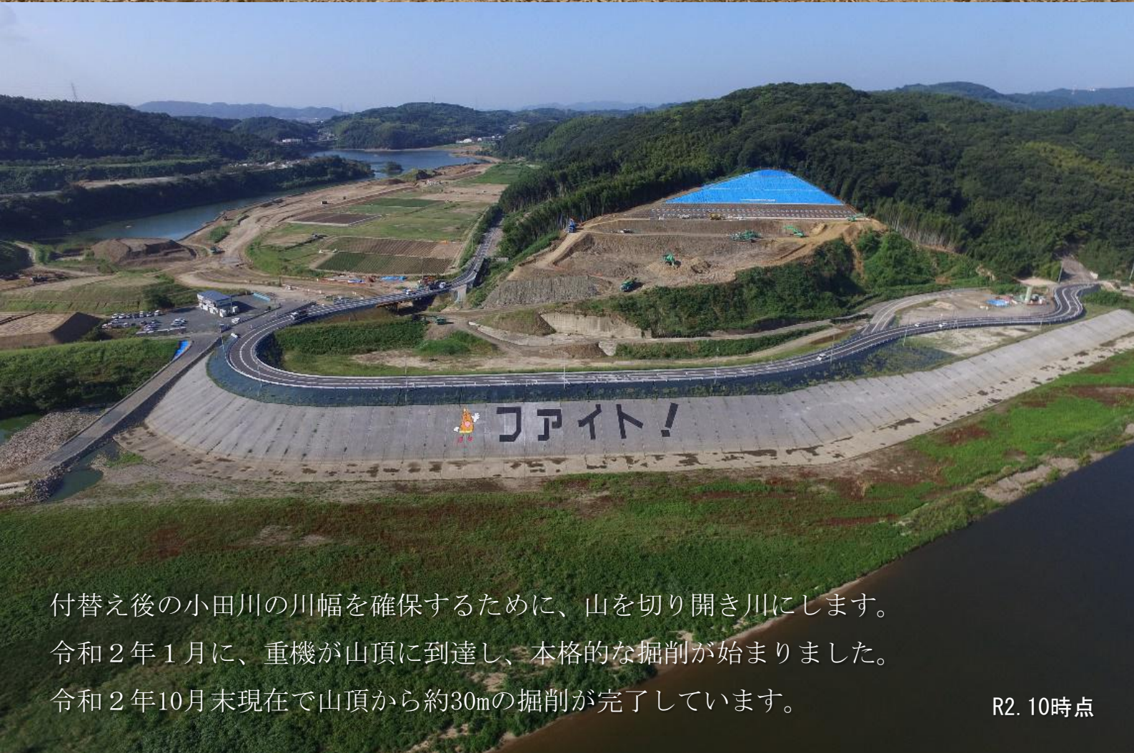
南山の掘削状況
