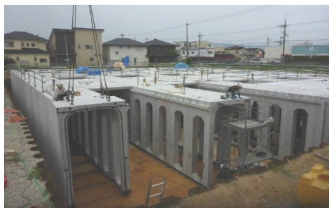
<貯留槽(地下に施工)>
