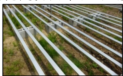
図-22 軽天材を使用したトレイ台 (豊並樹苗生産組合)
