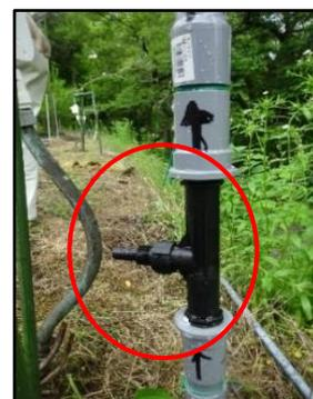
図-27 ナノバブル装置の設置
