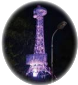
OHK岡山放送電波塔
