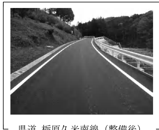
県道 栃原久米南線（整備後）
