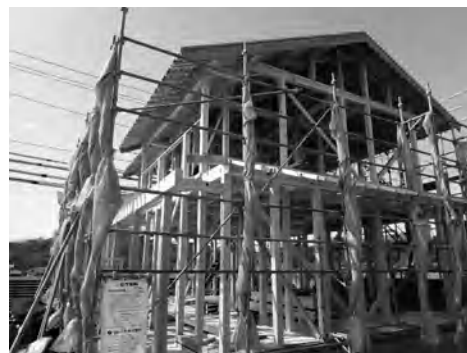
県産森林認証材の使用(木造住宅)
