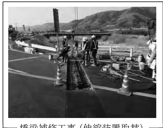
橋梁補修工事（伸縮装置取替）
