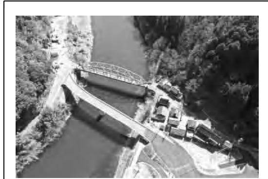
県道 落合建部線(且土橋)
