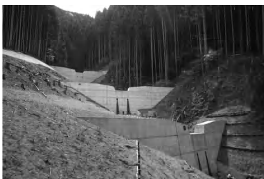
谷止工による荒廃森林の整備
