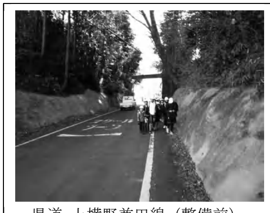
県道 上横野兼田線（整備前）
