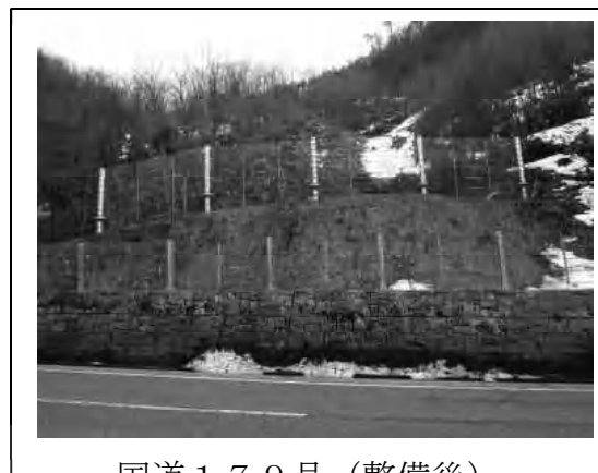
国道179号（整備後）
