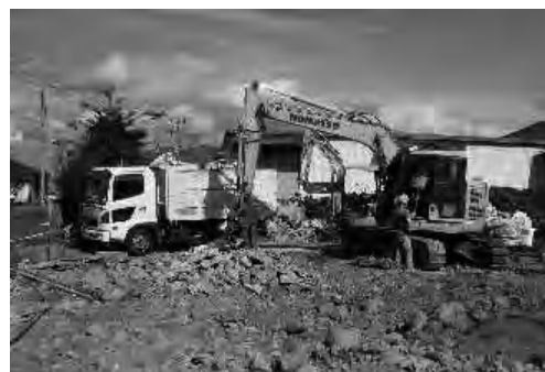
解体現場の様子
