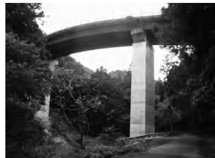
農道の保全対策(橋梁耐震補強)
