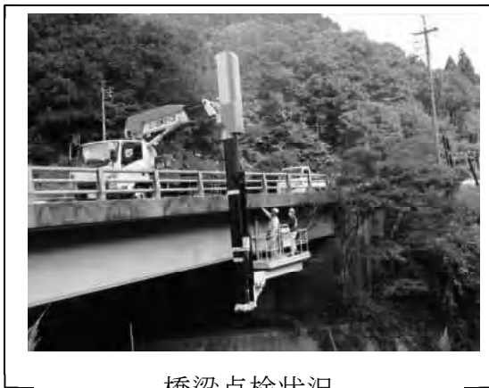
橋梁点検状況
