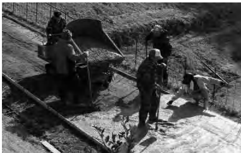
多面的機能支払（農道の砂利舗装）
