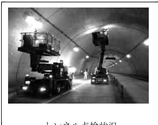
トンネル点検状況
