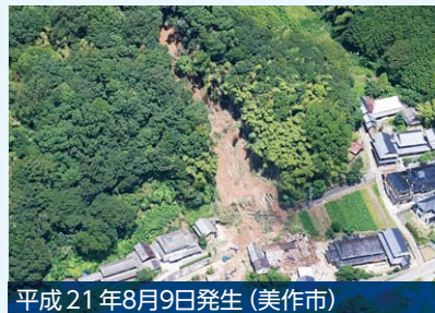
平成 21年 8月 9日発生(美作市)
