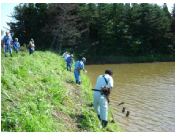
ため池堤体の草刈り
