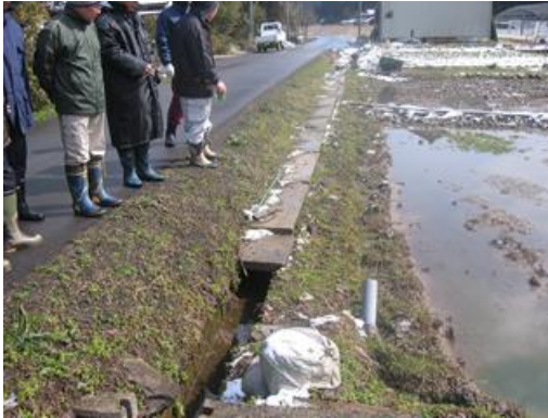
開水路の点検状況
