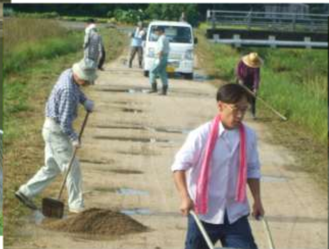
農道の保安全管理（路面への砂利補充）
