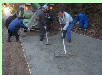
直営施工によるため池管理道の舗
