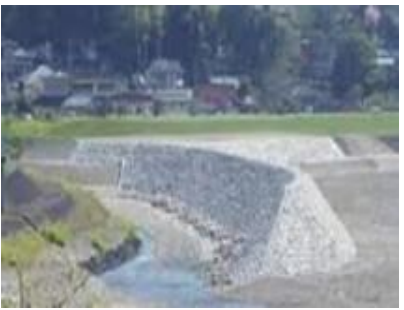
土石流の流れる方向を制御する導流堤の例
