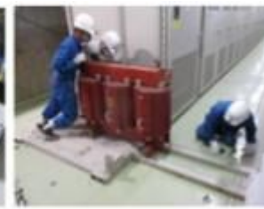
DOP-1高周波電源室解体撤去作業の状況
