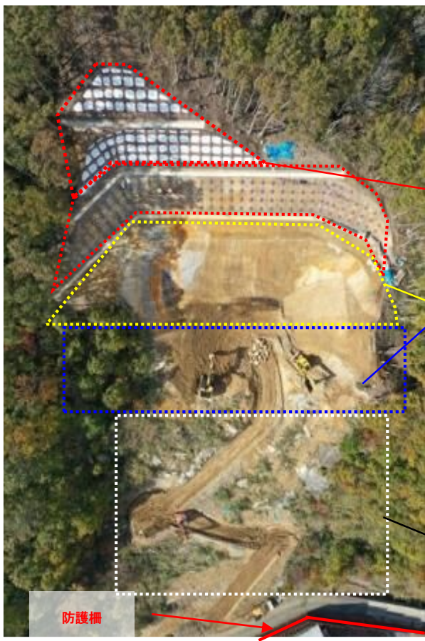
小規模な地滑り発生地における安全対策工事 (令和4年度～)
