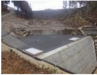
地滑りの未然防止工事として、設置した堰堤 (平成30年度・鉾さいたい積場の下流側斜面)
