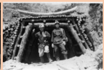
(坑道掘削による探鉱・採掘)
