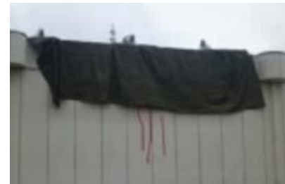
外壁の破損を想定した養生訓練
