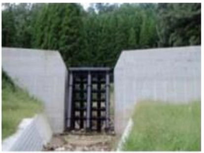
砂防堰堤の例
