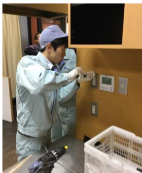
(カフェの電気配線工事)
