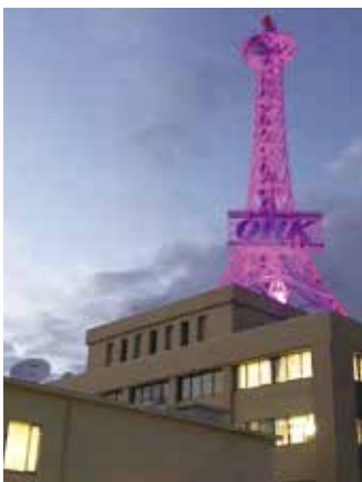
OHK岡山放送電波塔
