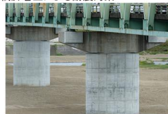
橋脚巻立による耐震対策
