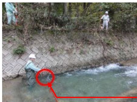
ポールを差し込み、洗堀を確認する
