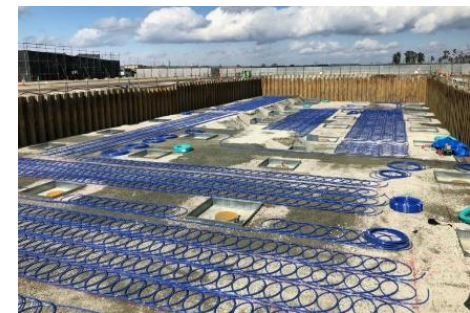
地中熱回収システム 敷設状況
