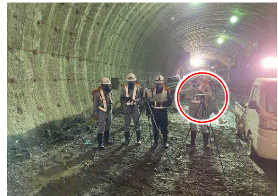
【会議用スピーカーの設置（現場側）】
