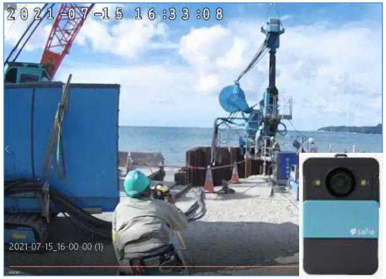
【立会状況(現場側)】
