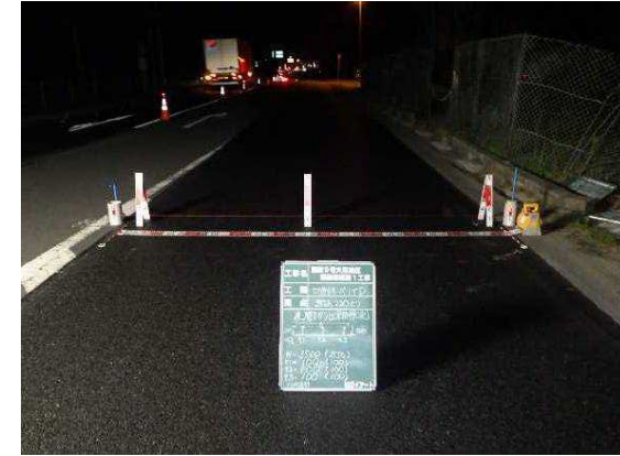
【夜間施工状況】
