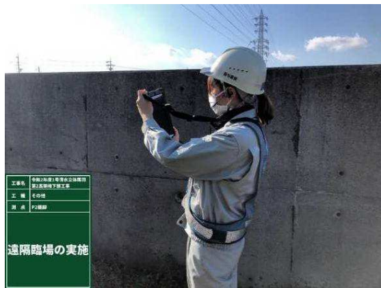
【立会状況（現場側）】
