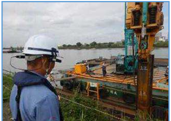
【立会状況（現場側）】
