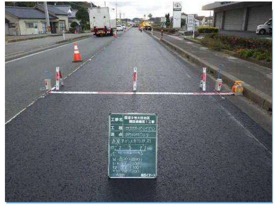
【昼間施工状況】
