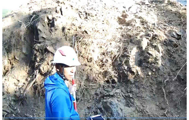
【立会状況画面（現場側）】
