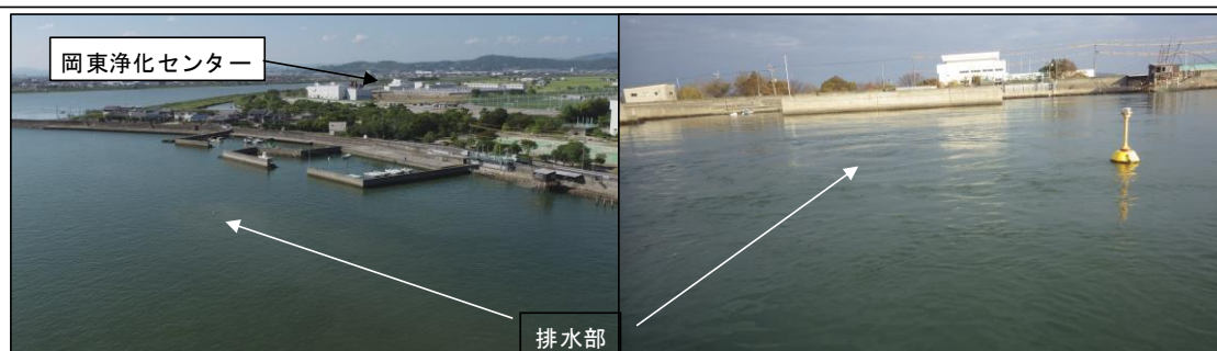
岡東浄化センターと排水部
