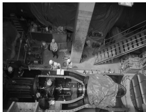
排水ポンプの分解整備
