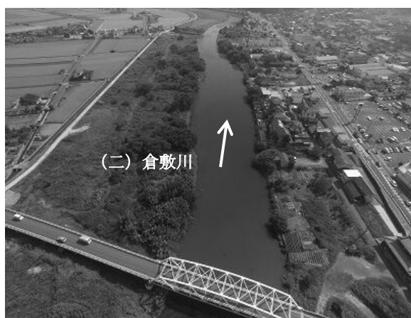
河道掘削着工前状況
