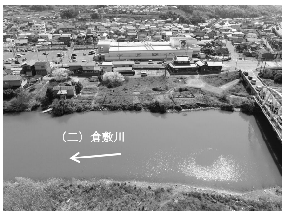
築堤着工前状況
