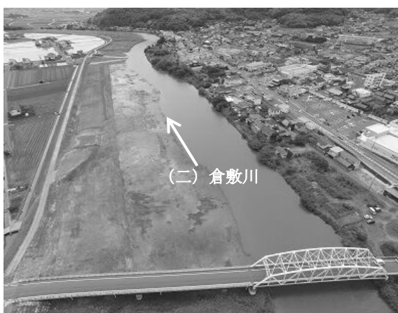
河道掘削施工後状況
