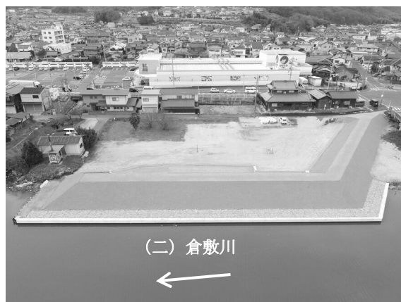
築堤施工後状況
