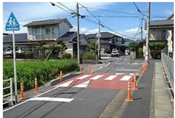
スムーズ横断歩道の試験設置
