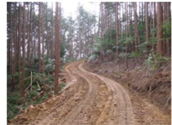
森林整備に欠かせない作業道
