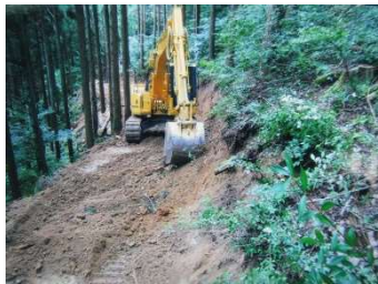
作業道の開設
