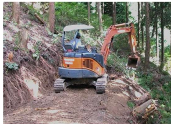
作業道の機能強化 (路面の補修等)
