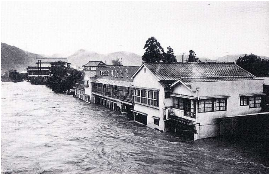
写真 1-2-2 昭和 47 年 7 月洪水による岡山市北区建部町建部上の八幡温泉の被災状況 岡山文庫 142「岡山の災害」より
