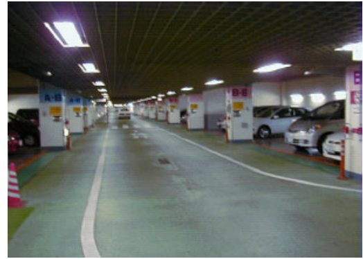
■表町地下駐車場（城下地下駐車場・岡山市）■
