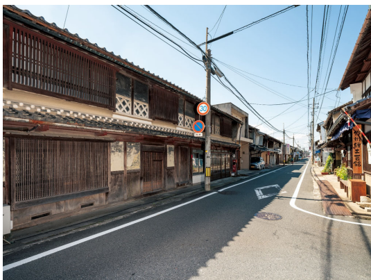
■城西伝統的建造物群保存地区（津山市）■
