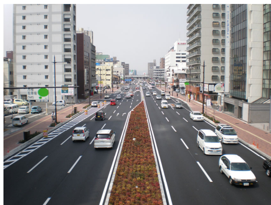
■久米東岡山線（岡山市）■
