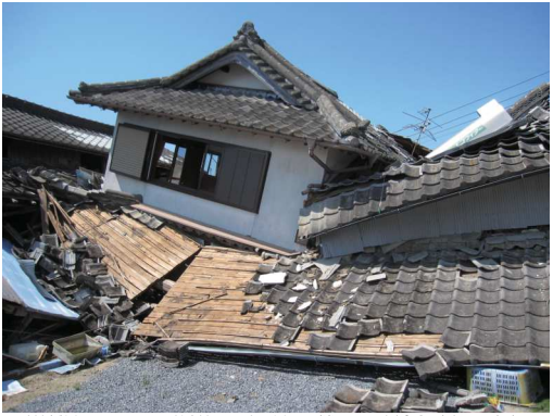
熊本地震では、益城町を中心に多くの木造住宅が倒壊・全壊の被害に遭いました。
