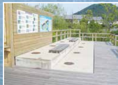
●水質浄化施設
