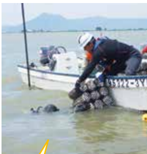
魚礁設置作業の様子
