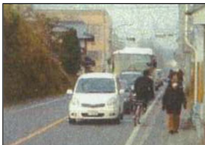
歩道が未整備で自動車と自転車・歩行者が輻輳し危険な状況
