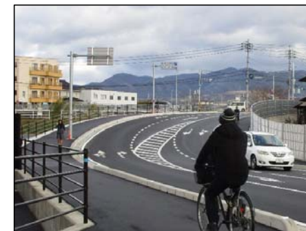
歩道設置による安全な自転車・歩行空間
