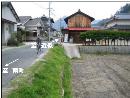
路肩が狭く歩道が未整備の現道
