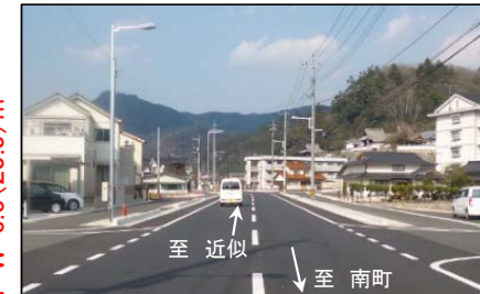
道路整備後の状況
