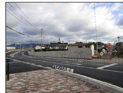
道路整備後の状況
