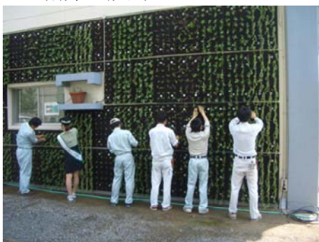
植栽中の状況
