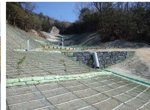
山腹工(浅口市地内)
