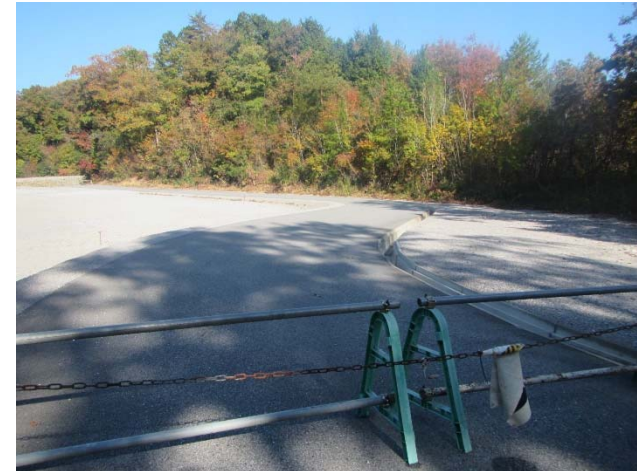
【転出】 資材置場 ▲2.24ha (新見市豊永宇山地内)
