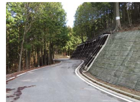
林道吹屋法曽線（新見市地内）
