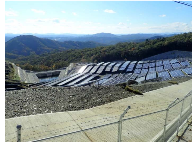
【転出】太陽光発電施設 ▲17.56ha (真庭市五名地内)
