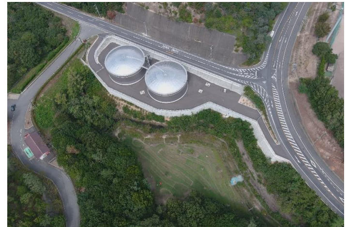
【転出】配水池築造 ▲0.22ha (玉野市玉原三丁目地内)
