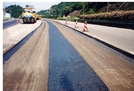
写真 2.6.2 シートの施工完了状態
