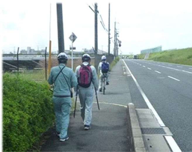
徒歩と自転車による管路点検
