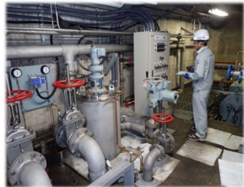
冷却水設備の巡視点検
