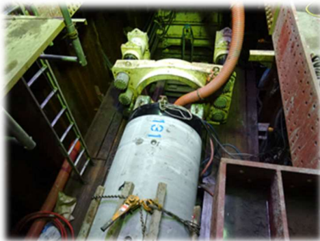
管路の上重化：推進工法
