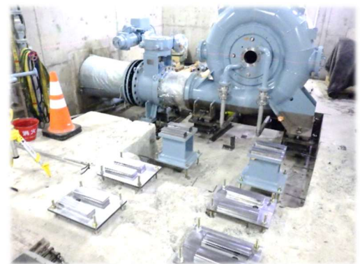
阿波発電所水車発電機等更新工事
