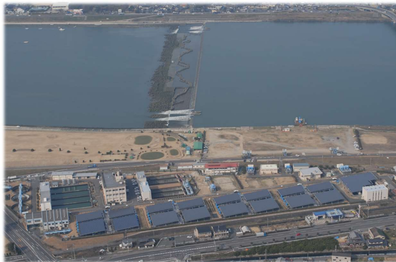
西之浦浄水場
