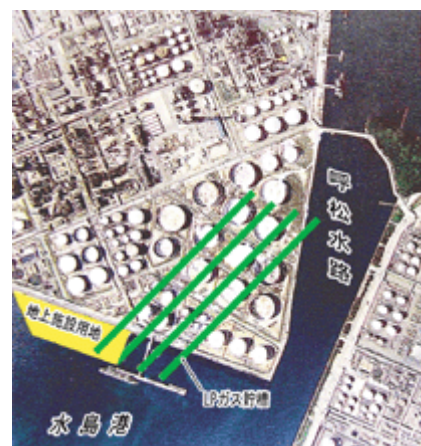
【写真説明】空から見たLPガス備蓄・倉敷基地の建設地 （4本線が地下貯蔵タンク） <山陽新聞社提供>
