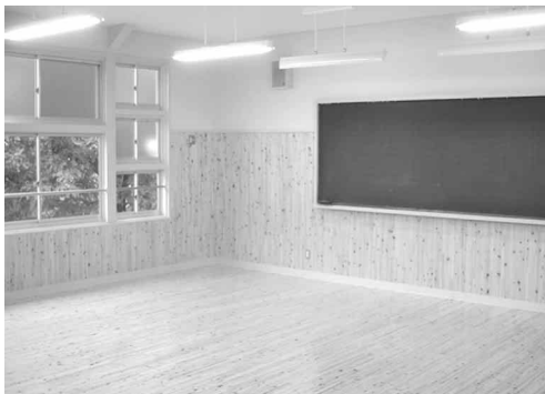
県産材を利用して床・壁が改修された別所小学校
