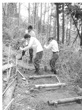
遊歩道の整備
