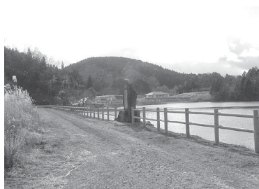
機能増進型整備 (木製ため池転落防止柵)
