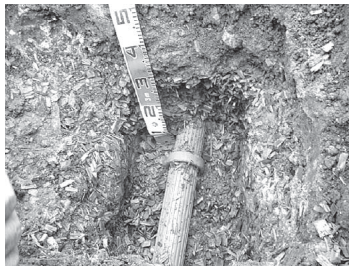
劣化状況調査
