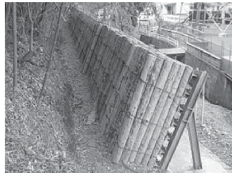
古タイヤを木材に交換した落石防護壁（高梁市松山）
