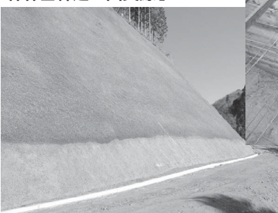
木材チップ吹付け工の施工現場 森林基幹道「因美線」
