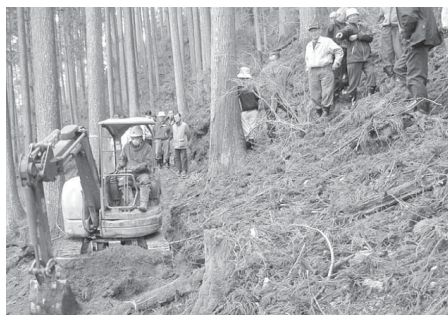
作業道作設現場視察(奈良県川上村)
