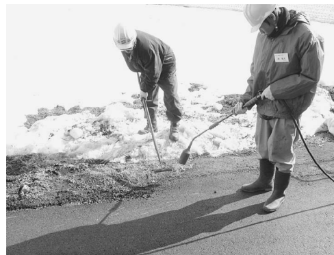
アスファルト舗装作業
