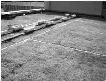
屋上緑化実証試験
