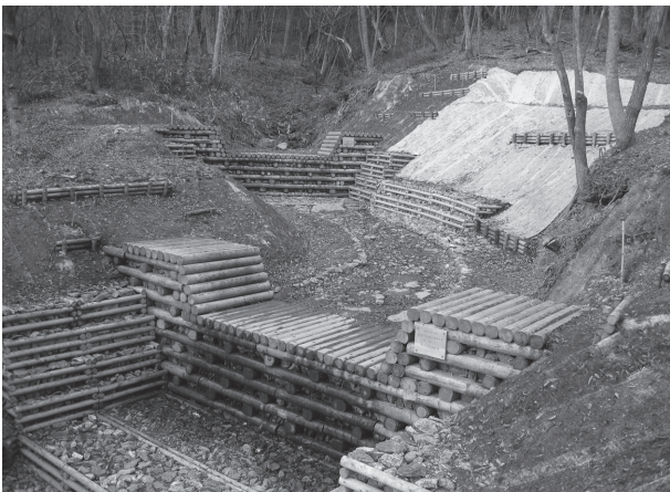
木製床固工 (真庭市蒜山上徳山地区内)
