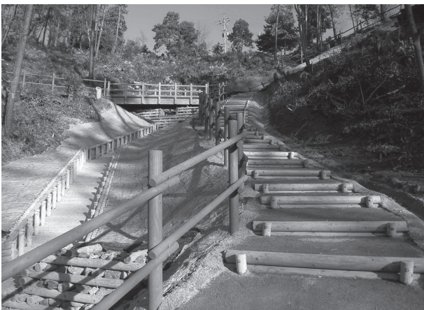
転落防止柵・丸太階段 (井原市経ヶ丸地区内)
