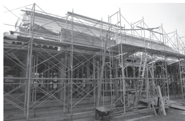
客殿新築工事の状況
