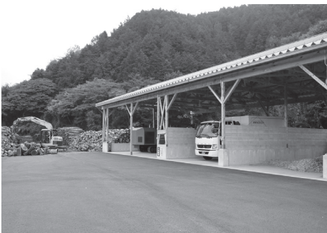
木質チップ・機械保管庫
