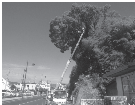
高所作業車での作業風景
