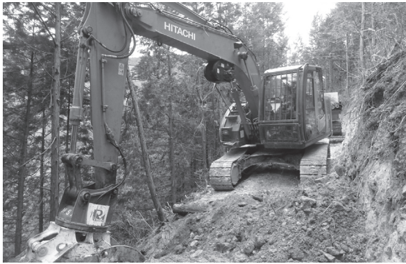
作業道の開設
