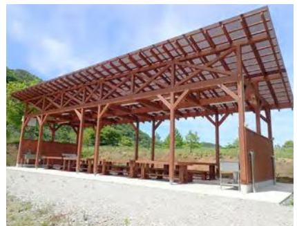
屋外調理場の全景
