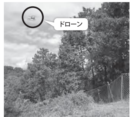
ドローンを使った柵の点検
