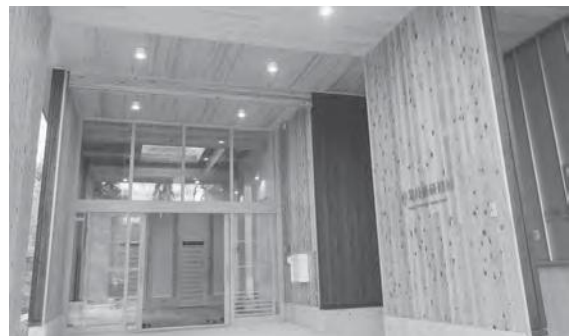
県が整備した公共建築物における県産材の利用 (森林研究所林業技術研修棟)
